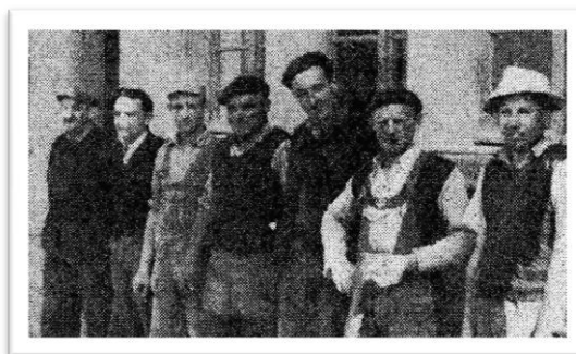
Ouvriers ayant participé aux travaux
